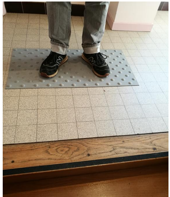
Les clous installés au sommet des escaliers
