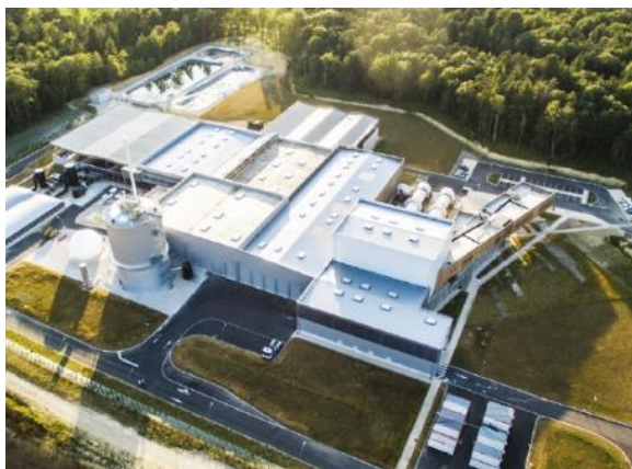
Ovade, l'usine de traitement des déchets de La Tienne
