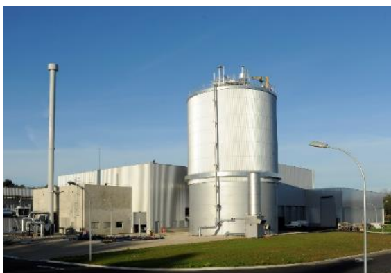
Le digesteur dans lequel se produit la méthanisation.
