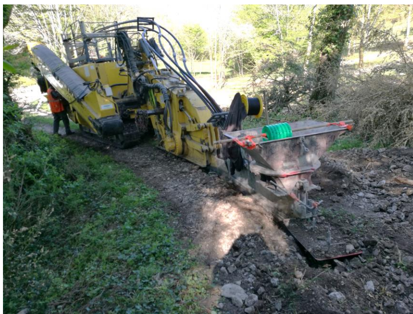
Les engins creusent les tranchées et y déposent les gaines des câbles.
