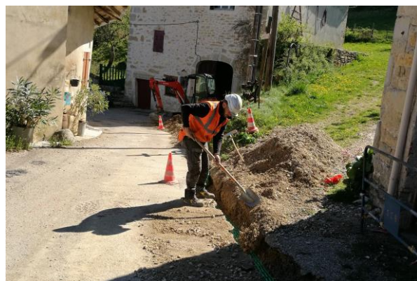
A Côte-Savin, la tranchée est vite rebouchée afin de ne pas gêner la circulation des véhicules déjà délicate à cet endroit.
