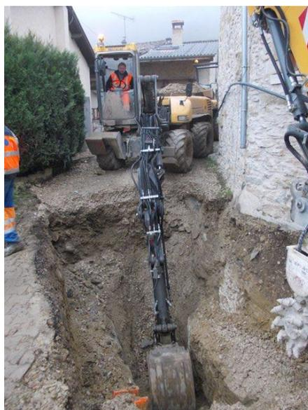
Creusement de la tranchée devant le four à 2,70 m. et ralentissement des travaux du à la présence de la roche. La tranchée dans sa partie la plus profonde au carrefour avec la route de Salaport descend à environ 3,50m. pour permettre de récupérer les maisons en contre bas.
