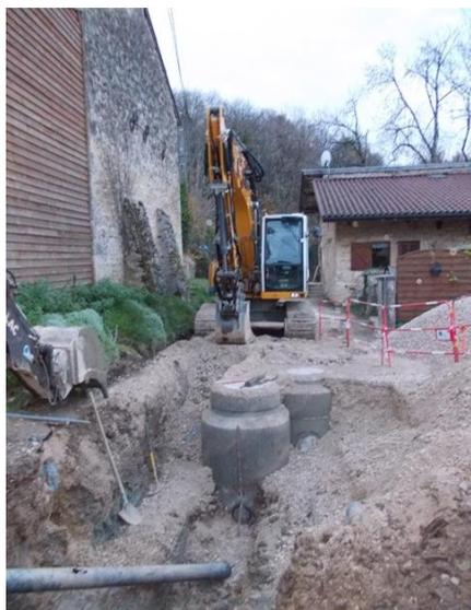
Ci-dessus : installation de deux regards, un pour l'assainissement à gauche, plus profond et un pour l'eau pluviale à droite, moins enterré.
