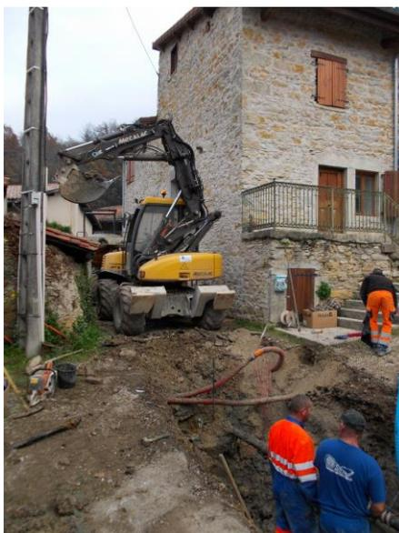
Ci-dessus : photo de la tranchée devant la fontaine, traversée par la conduite d'eau potable en fonte.
