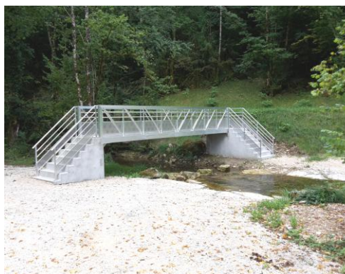
La passerelle sur l'Oiselon
