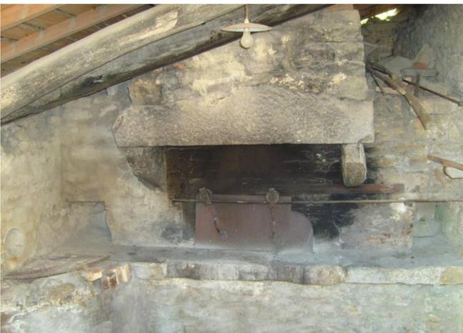
La voûte maçonnée du fournil empêchait le contact des braises avec la charpente. La "gueule" du four était obstruée par une porte métallique montée sur une coulisse horizontale.
