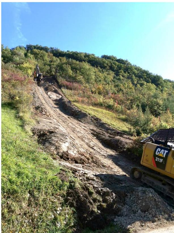
*Il a fallu une pelle-araignée pour pouvoir creuser la tranchée dans cette pente vertigineuse !*
