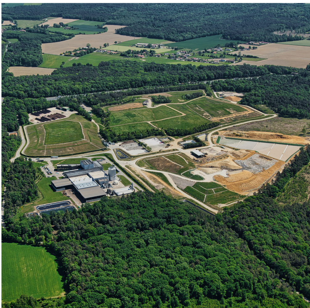
Vue aérienne des installations du site de la Tienne - Organom
